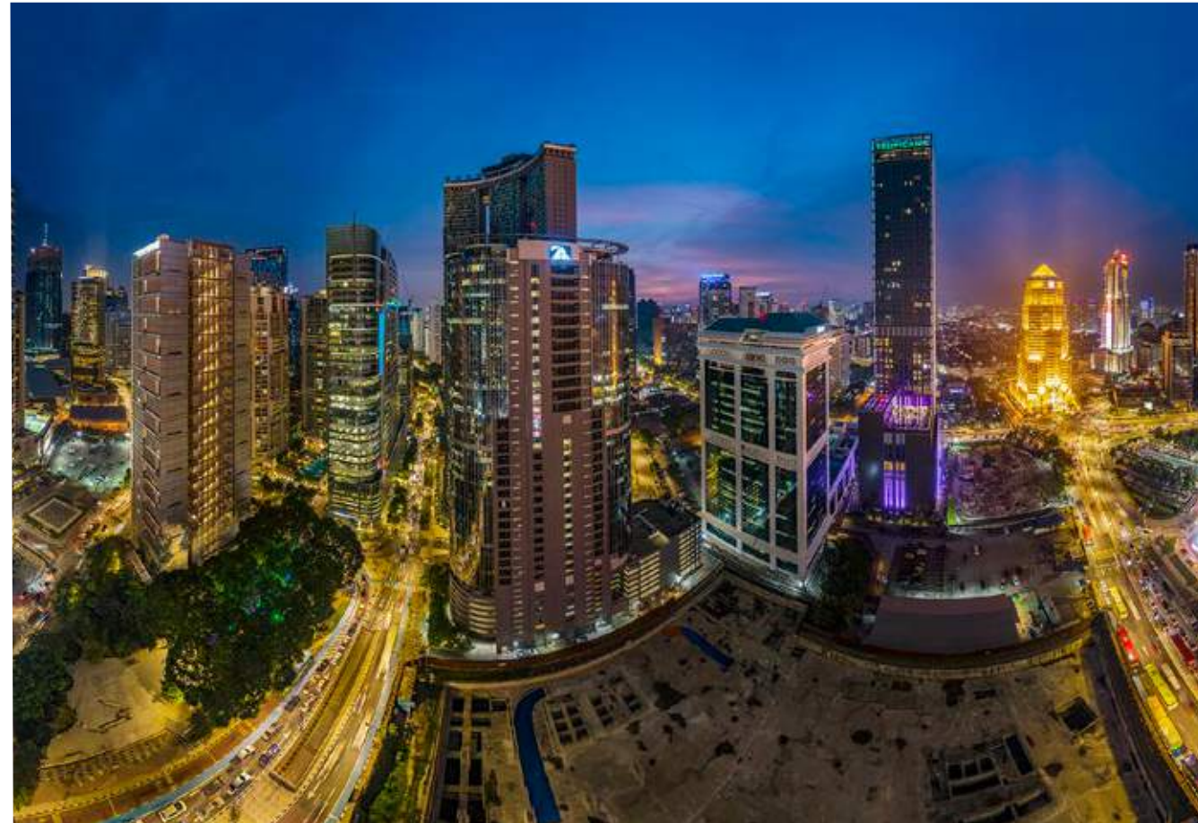
— MENARA TA ONE, KUALA LUMPUR MALAYSIA
